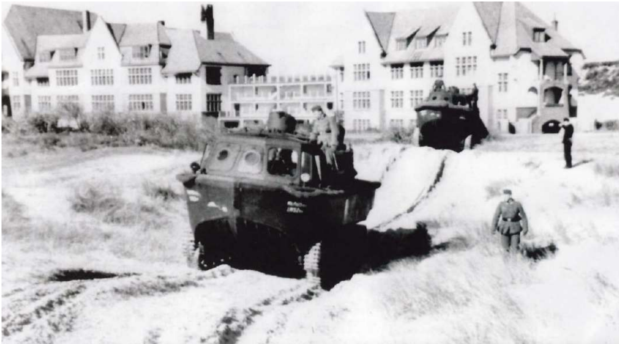
Další snímek testů prototypů LWS I v Belgii. Vysoká silueta vozidla ztěžovala pohyb vozidla i v nepříliš náročném terénu pobřežních písečných dun
