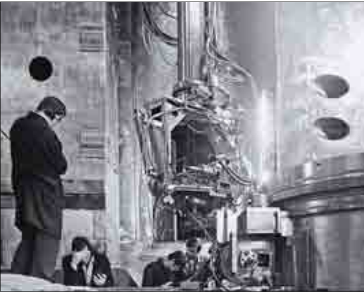
Наладочные работы на блоке электронно-лучевых пушек и систем слежения за свариваемым стыком на установке ЭЛУ-24
