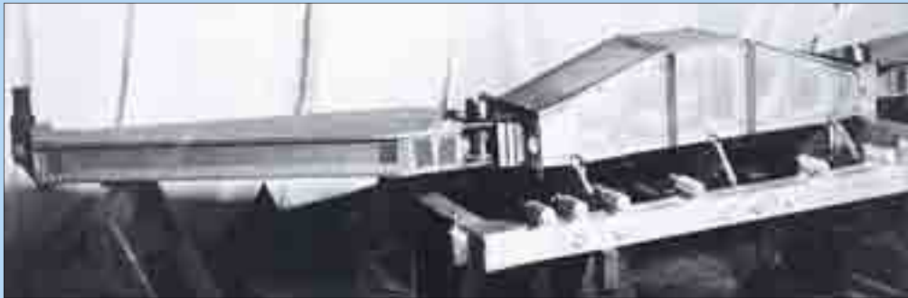
МОДЕЛЬ ШАРНИРНОГО СОЕДИНЕНИЯ ЦЕНТРАЛЬНОЙ БАЛКИ С КОНСОЛЯМИ КРЫЛА
