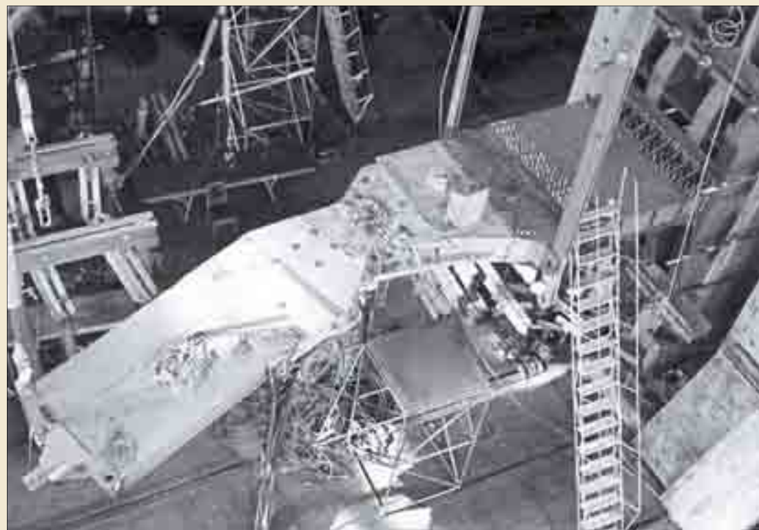
Испытания на модели шасси Ту-160 по определению ударных нагрузок
